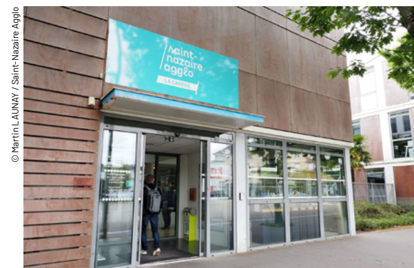
Entrée du siège de Saint-Nazaire Agglomération / la CARENE.
