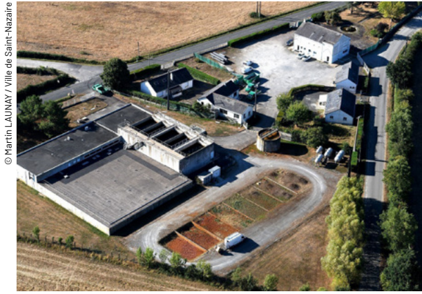
Usine de production d'eau à Campbon.
