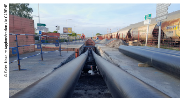
Travaux de déploiement du réseau de chaleur ESTER.
