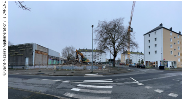
Démolition du centre commercial de la Trébale.
