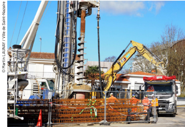
Travaux de création d'un bassin de rétention des eaux usées et d'un poste de refoulement à Villès-Martin.
