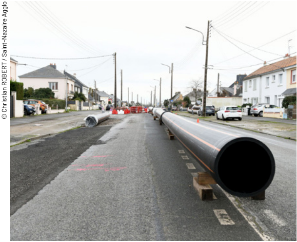
Travaux de renouvellement de conduites d'eau.
