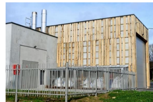
Chaufferie de Donges
