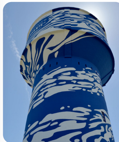
Château d'eau de la Cordonnais, Montoir-de-Bretagne
