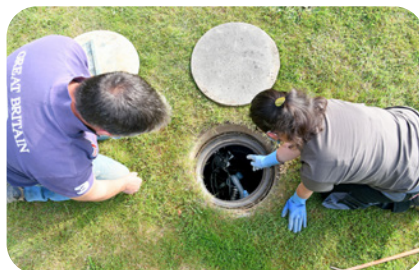
Intervention du SPANC
