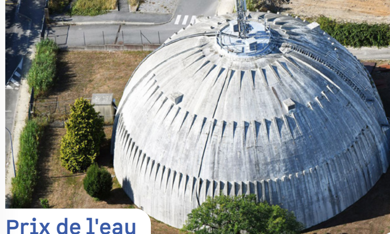
Château d'eau, site du Plessis, Saint-Nazaire
