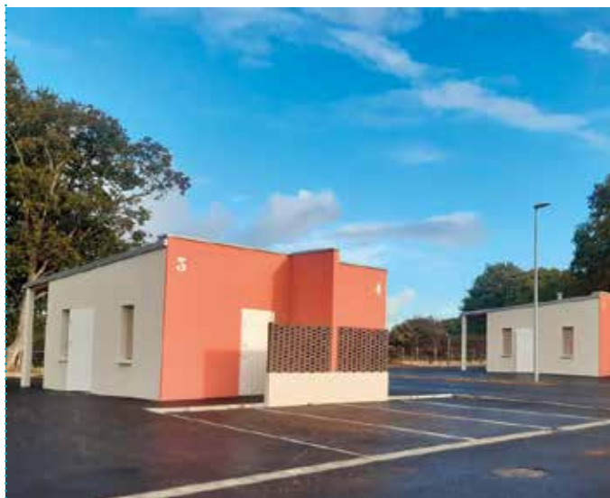
Aire d'accueil des gens du voyage, Pornichet
