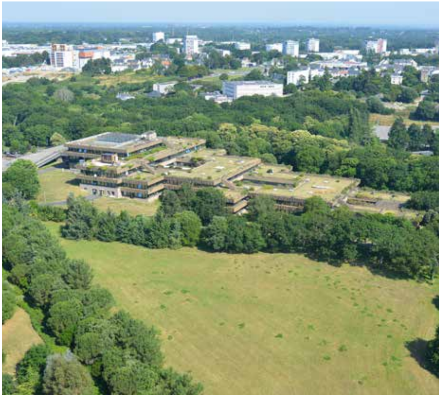
insertion paysagère du bâti existant © Ville de Saint-Nazaire
