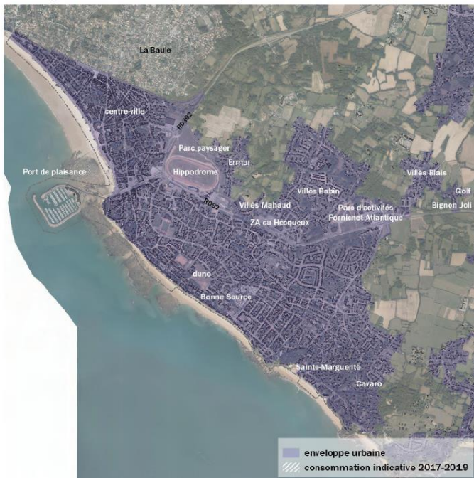
La zone agglomérée de Pornichet (extrait de la justification des choix DU PLUi)
